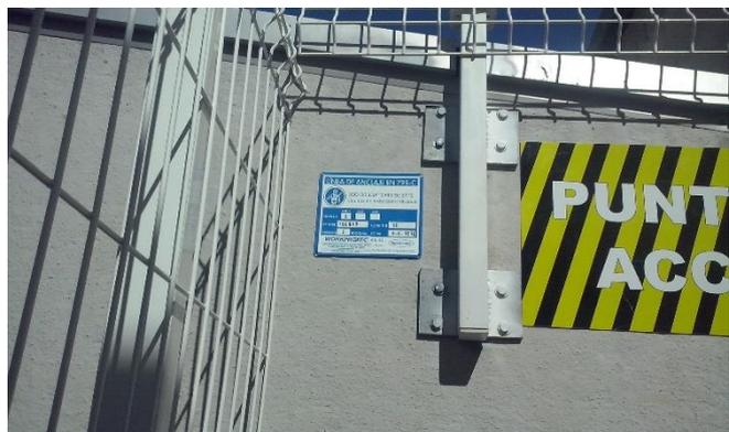
**Fotografías ejemplo de líneas de vida para la utilización de arnés de seguridad.**
