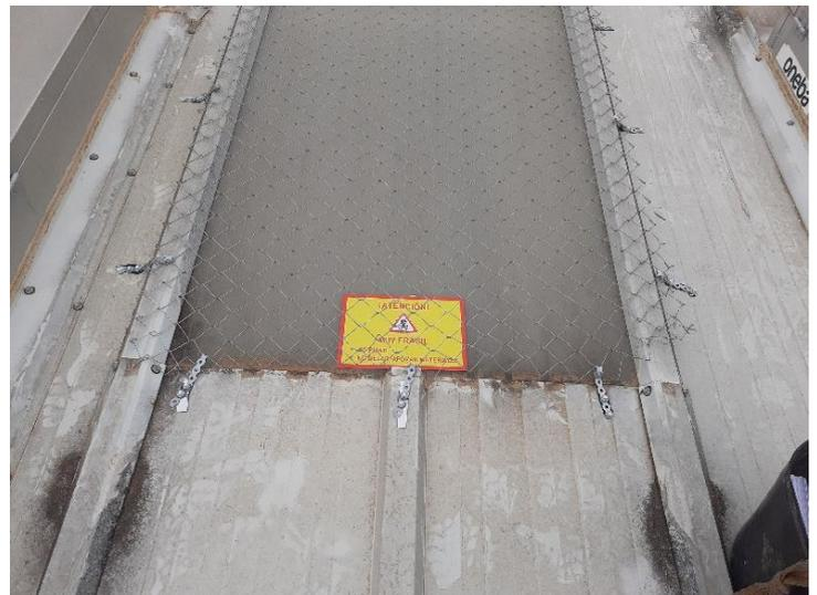
*Fotografías ejemplo de placas traslucidas, claraboyas o lucernarios no suficientemente resistentes señalizados y protegidos.*
